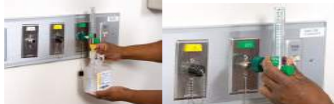
سیلندر اکسیژن و مانومتر را چک و بررسی کنید (از نظر پر بودن کپسول و عدم نشتی و وجود آب مقطر در سیستم مرطوب کننده)
